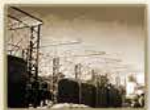
Início de uma nova estrutura.
